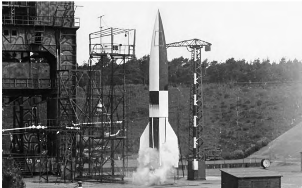
Aggregat 4 (A4), vor allem unter dem nationalsozialistischen Propagandabegriff V2 bekannt, war die Typenbezeichnung der im Jahr 1942 weltweit ersten funktionsfähigen ballistischen Rakete mit Flüssigkeitstriebwerk. Abgebildet ist eine A4 beim Start, Prüfstand VII, 1943
